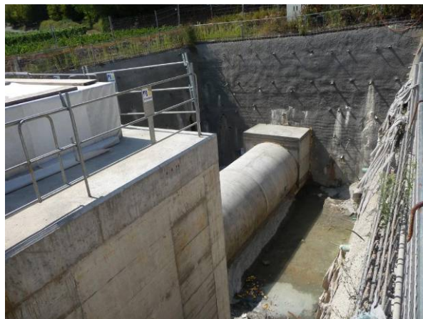
Figure 15 : L'ouvrage 116 dans le puits de sortie
