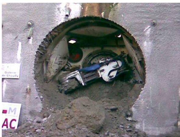
Figure 20 : Percement de la galerie de Chouilly
