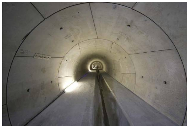
Figure 13 : Vue intérieure de la galerie terminée
