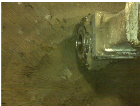
Figure 18 : Excavation à la fraise dans la molasse
