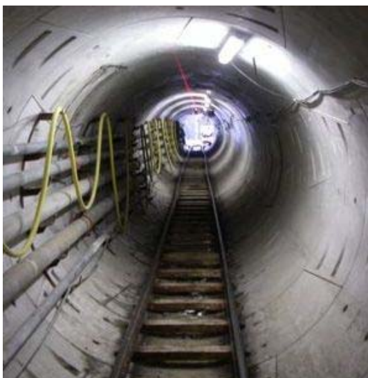
Figure 12 : Vue intérieure du revêtement en place
