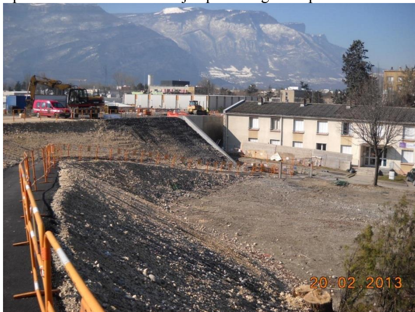
Suivi des tassements d'une plateforme de tramway fondée sur remblai.
