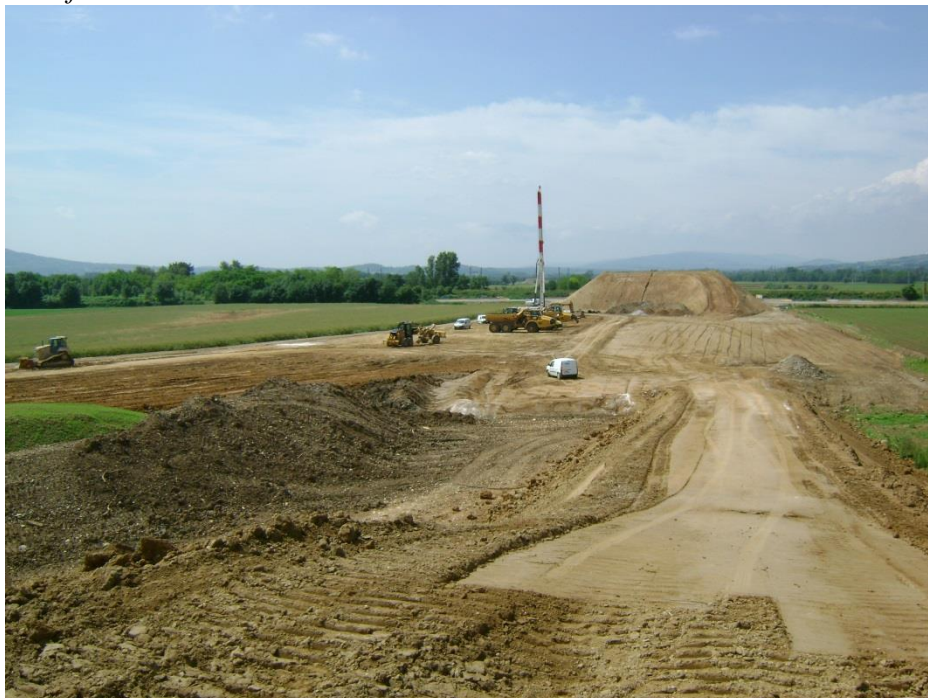
Suivi des tassements d'un remblai de préchargement d'une plateforme autoroutière.
