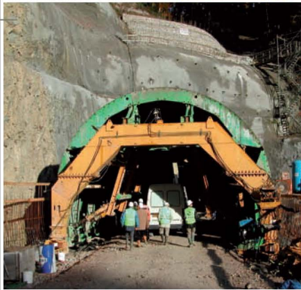
■ Tunnel et nouveau pont de l'Église à Reyvroz (74) Études d'exécution
