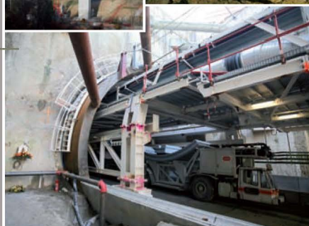
■ A41N Tunnel du Mont Sion (74) Assistance à Maîtrise d'Ouvrage
