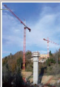
■ A41N Viaduc des Ussets (74) Assistance à Maîtrise d'Ouvrage
