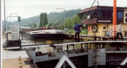
Écluse de Grevenmacher sur la Moselle Luxembourg Étude de sécurité
