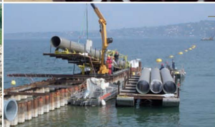
Conduite sous-lacustre dans le lac Léman (GE) Maîtrise d'œuvre
