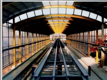
■ Centre de nettoyage principal CFF (GE) Maîtrise d'œuvre
