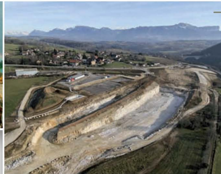
■ A41N Tranchée Couverte de Noiret (74) Assistance à Maîtrise d'Ouvrage
