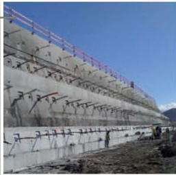
■ A41N Murs ancrés de Troinex (74) Assistance à Maîtrise d'Ouvrage
