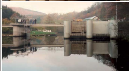
Barrage sur la Sure Luxembourg Diagnostic et étude de sécurité
