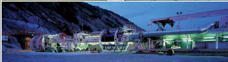
■ Tunnel ferroviaire du Lötschberg (CH) Maîtrise d'œuvre
