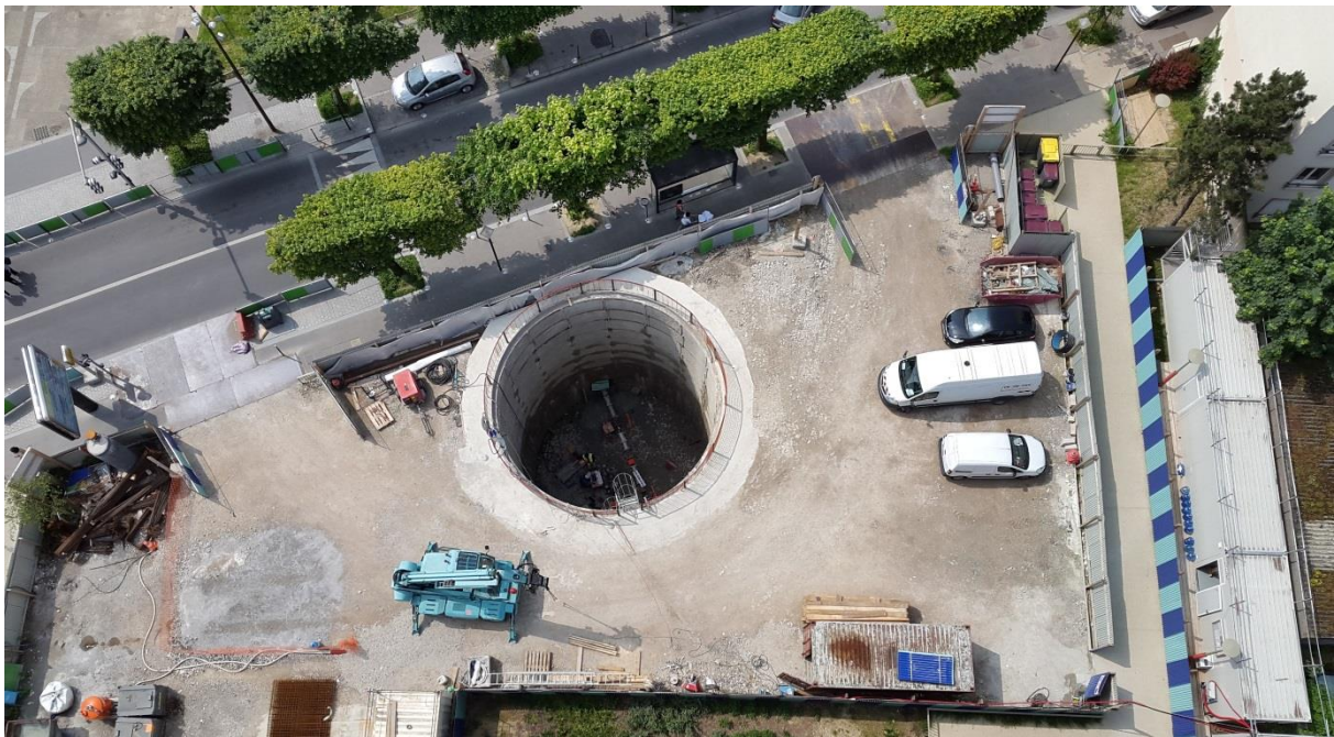
Figure 1. Vue en plan du Puits Calmette – Essais géotechniques en cours.
