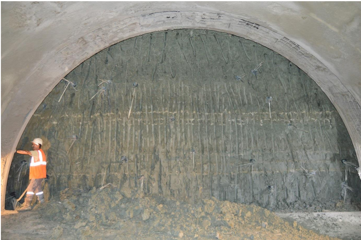
Figure 2. Front de la demi-section supérieure de la galerie.
