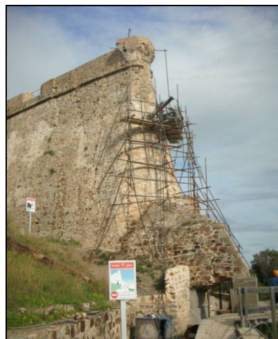
Figure.15. Travaux de confortement des maçonneries par clouage. Nailing works.
