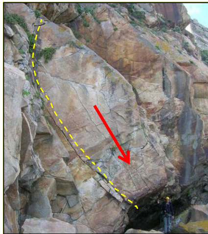
Figure.7. Mécanisme de rupture par glissement plan/dièdre par perte de la butée de pied. La personne à la base du bloc donne l'échelle. Plan failure mechanism.
