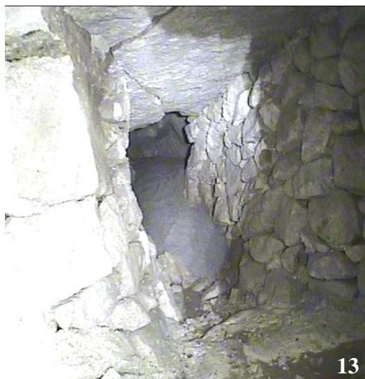
13-14 : Carrière souterraine - Fractures du toit 15 - Mortier en place dans la cavité
