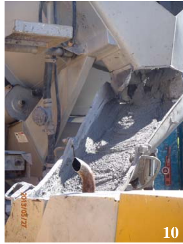
9 - Foreuse 10 - Livraison de mortier 11 - Essai d'affaissement 12 - Dispositif d'injection
