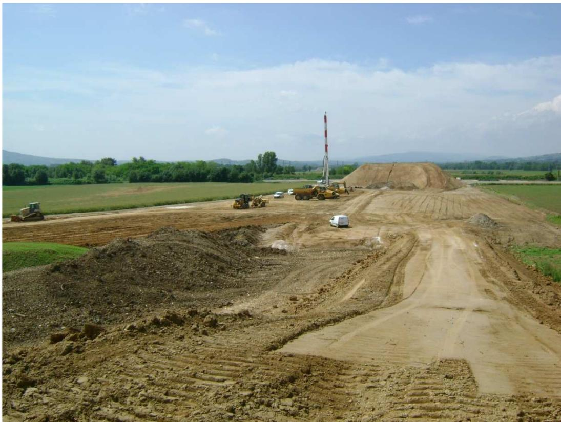
Figure 4 : Suivi des tassements d'un remblai de préchargement d'une plateforme autoroutière
