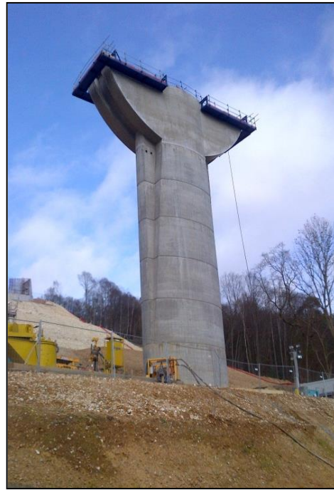
Figure 8b. Pile P1 achevée
