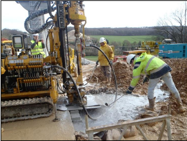
Figure 5a. Réalisation du plot d'essais de jet grouting
