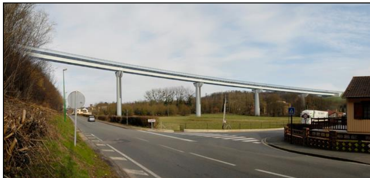
Figure 1. viaduc de l'Austreberthe (© GIE A150)
