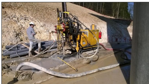
Figure 7a. Colonne de jet grouting avec pompage des spoils
