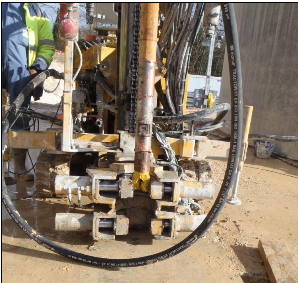
Figure 4a. Tête de forage avec tricône et buse de pour jet grouting
