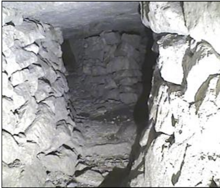
Figure 1. Carrière souterraine sous la ligne de Tramway.
