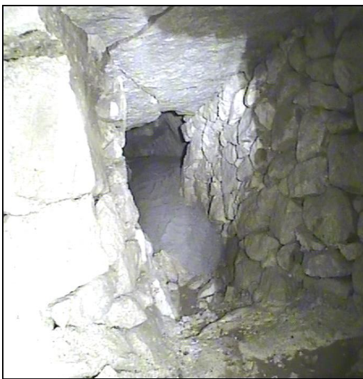
Figures 7 et 8. Carrière souterraine – Fractures du toit
