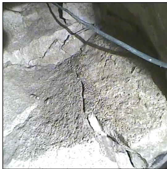
Figures 7 et 8. Carrière souterraine – Fractures du toit
