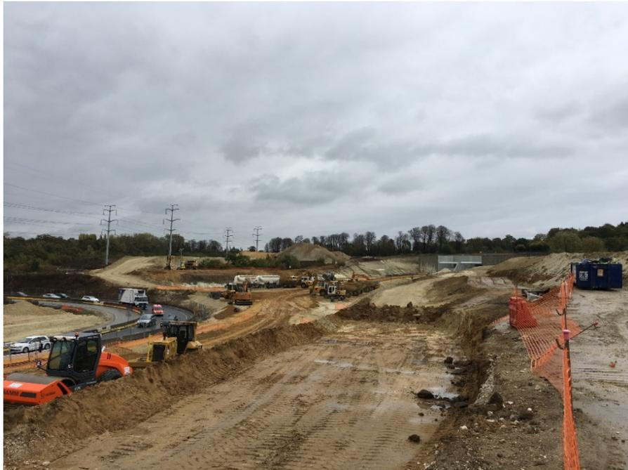
Les travaux ont débuté avec les terrassements en grande masse de la rampe Nord et la réalisation du bassin d'assainissement (figure 11). Le réseau de suivi piézométrique a été complété afin de vérifier le bon fonctionnement des tranchées drainantes du talus Est (rabattement des circulations).
